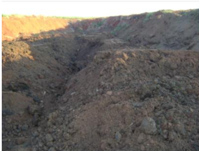
Figura 5: Cava com resíduos aparentes já decompostos.
