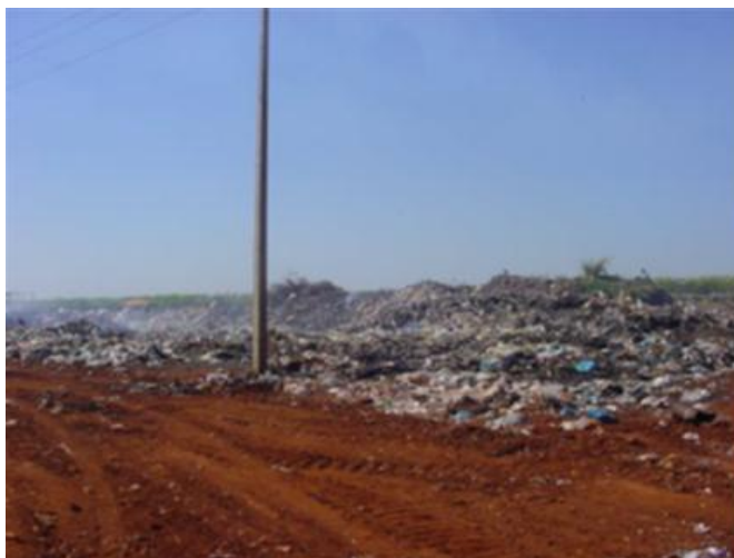
Figura 2: Visão do vazadouro sofrendo a ação de queima dos resíduos dispostos no solo na época da operação.
