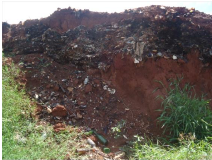
Figura 4: Visão de corte na cava existente demonstrando a queima dos resíduos dispostos no local.
